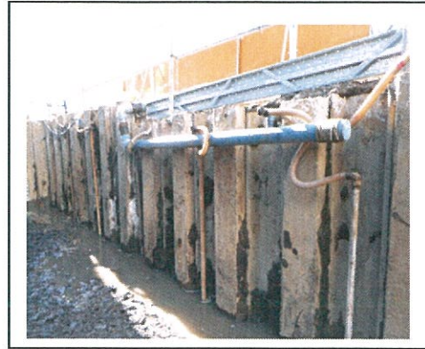
地下水揚水処理（ウエルポイント）
