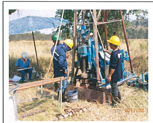
タイのボーリング調査状況
