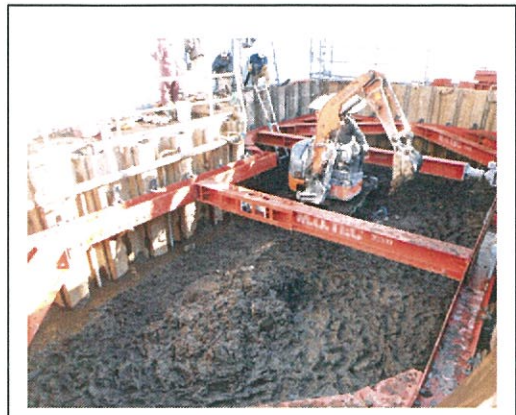
掘削除去の工事現場
